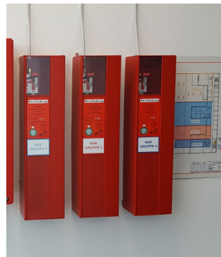
Abb. 41 Auslöseeinrichtung Rauch und Wärmeabzug
