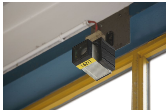
Abb. 35 Lichtschraken-Rauchmelder
