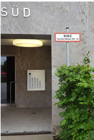
Abb. 32 Beschilderung einer Brandmeldeanlage vor einem Gebäude
